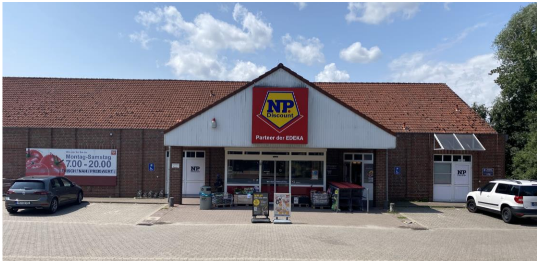
Abbildung 15: NP-Standort an der Alten Braunschweiger Straße
