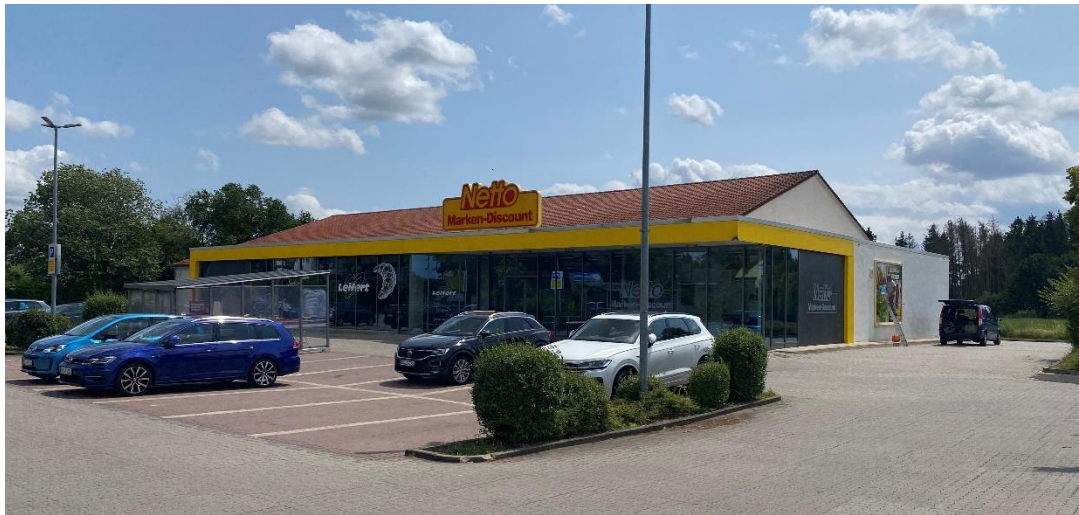
Abbildung 9: Netto, Alte Berliner Straße (Ortsteil Flechtorf)
