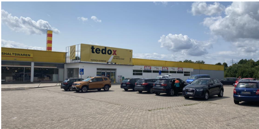
Abbildung 19: Netto-Standort an der Alten Braunschweiger Straße
