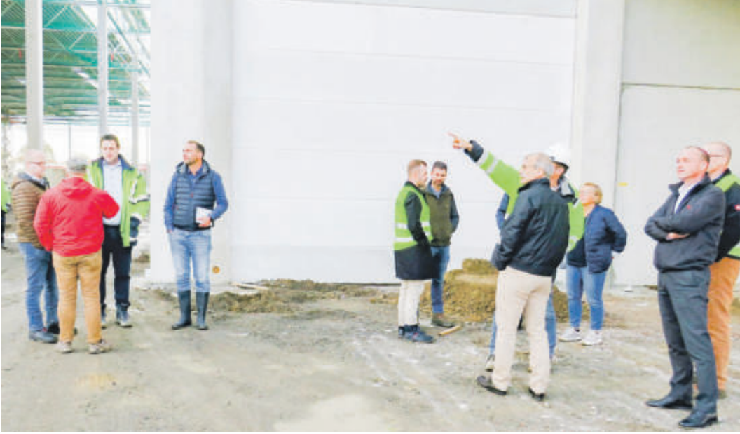
Der Gemeinderat Lehre und der Ortsrat Flechtorf informieren sich über die Arbeiten im Gewerbepark Flechtorf
