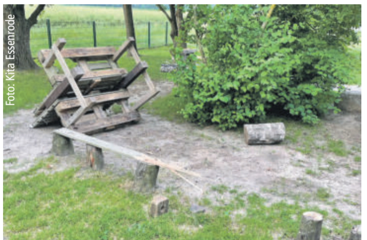
Unbekannte verwüsteten den Außenbereich der Kita.
