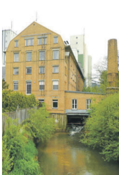
Flechtorfer Mühle (Fotos: c/o Flechtorfer Mühle)
