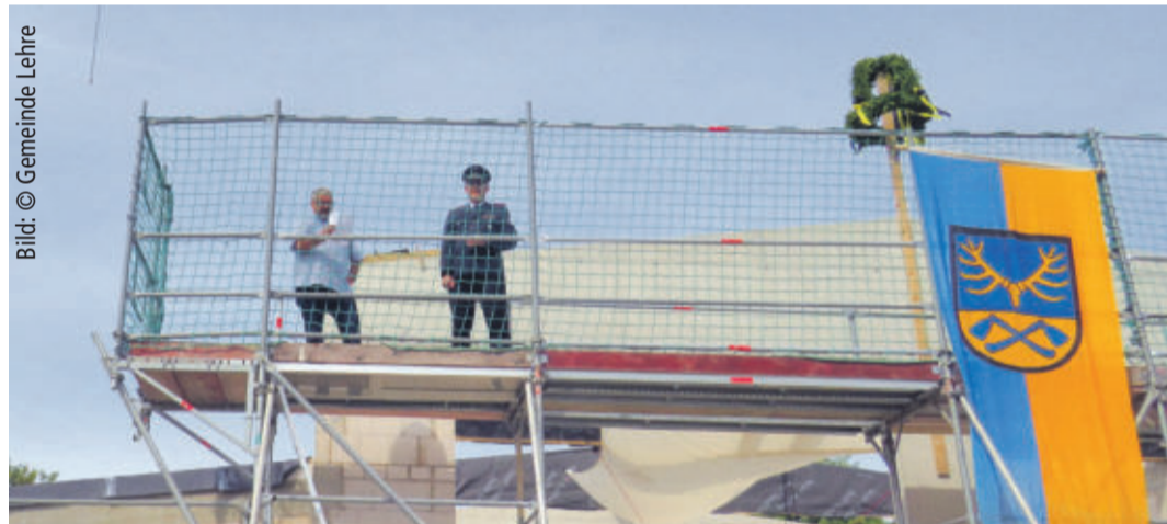
Wolfgang Saler (links) und Ortsbrandmeister Holger Schlenzig bei dem Richtfest des neuen Feuerwehrgerätehauses in Groß Brunsrode
