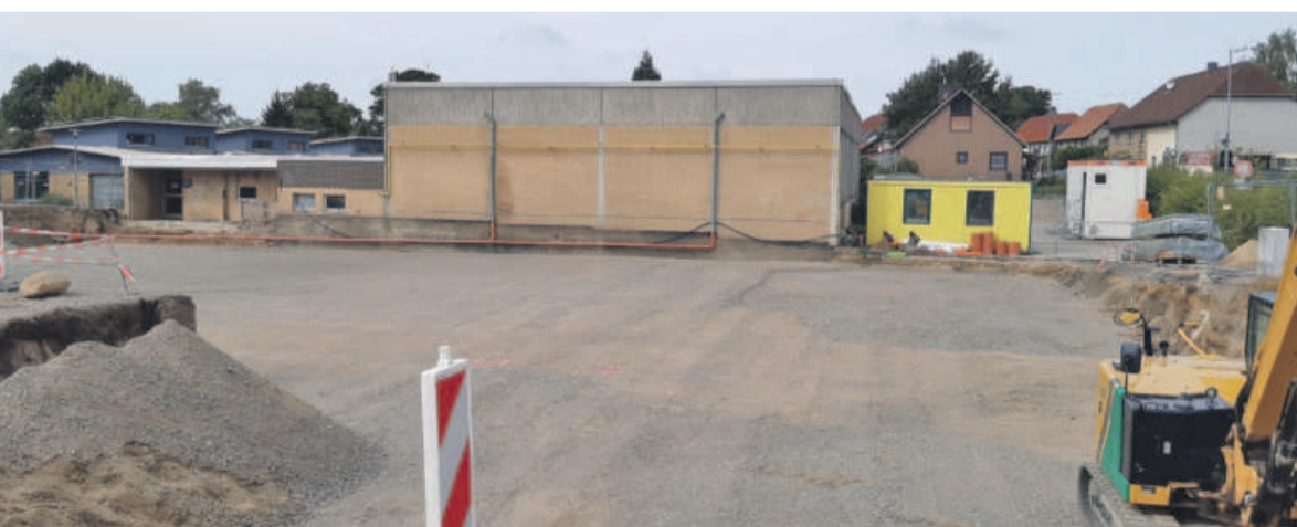
Hier entsteht die erste Hälfte der neuen Sporthalle in Flechtorf.
